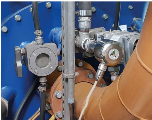
Der LAMTEC Flammenwächter F200K in Betrieb.
