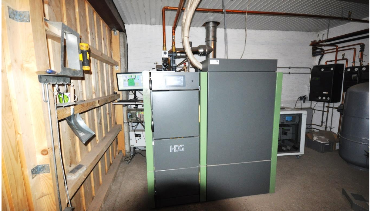
Abbildung 14: Bei der Praxiserprobung eingesetzter handbeschickter Vergaserkessel (Typ F-Kessel) der Firma HDG GmbH.
