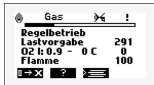
Fig. 7-4 Anzeige bei CO-Regelung
