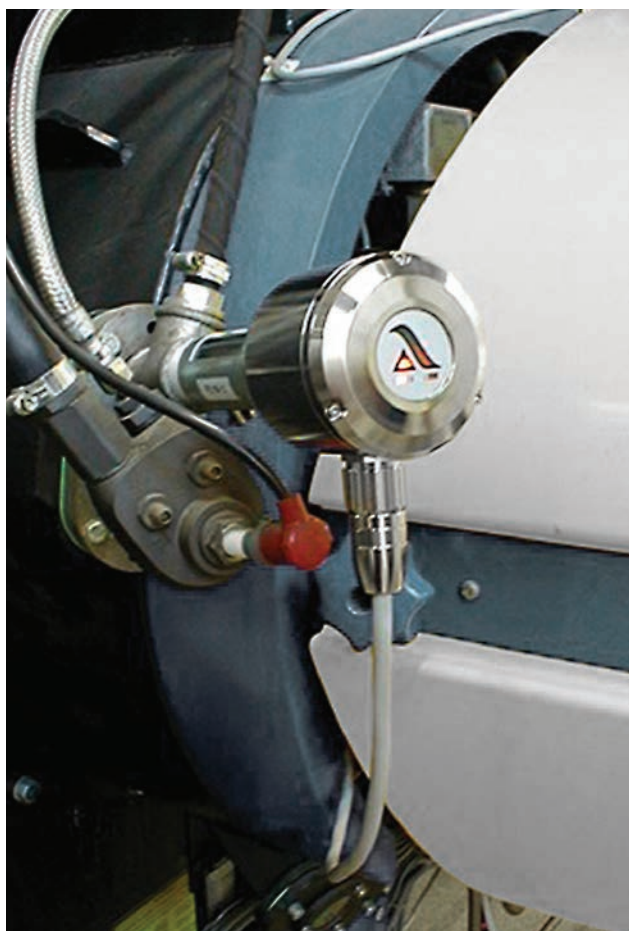
Skaner płomienia F200K firmy LAMTEC w użyciu.
