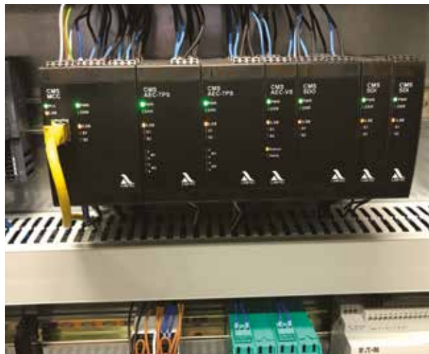
安装于控制箱中的CMS模块
