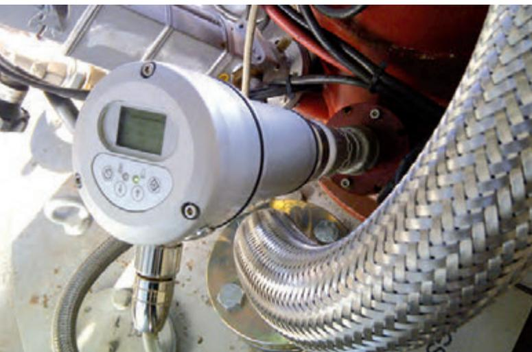
**Auch in Mehrbrenneranlagen zuverlässige selektive Überwachung.**
